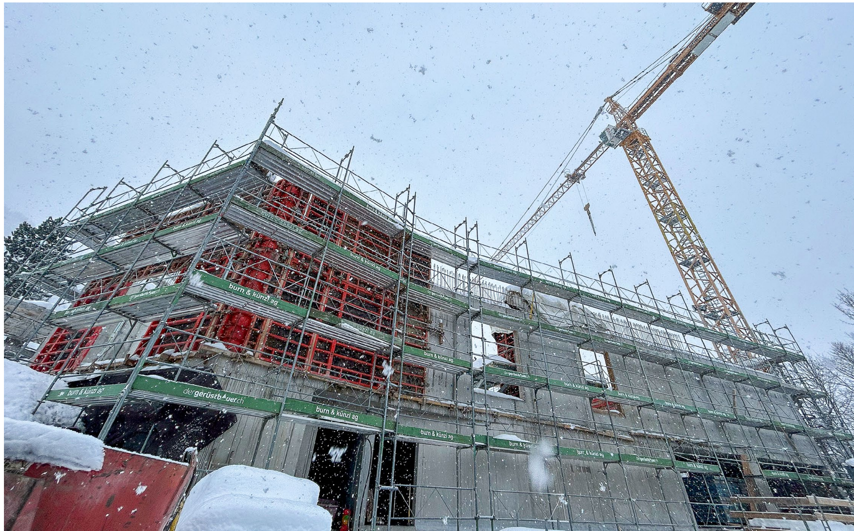
Der grosse Neubau wächst aus der 19 Meter tiefen Baugrube in die Höhe. Im Endzustand wird die Fassade mit Holz verkleidet (Bild unten).
